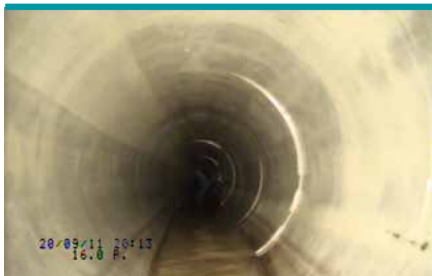
Tubería Rehabilitada
