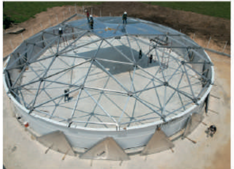
Inicio de armado del domo geodesico
