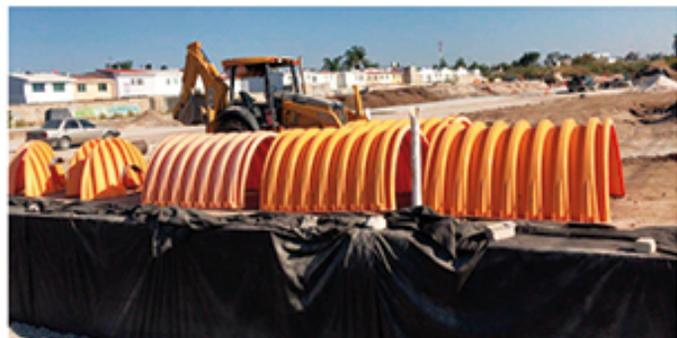
Los sistemas ADS StormTech son la solución ideal para controlar el flujo pluvial extraordinario en zonas urbanas, aísla los sedimentos y contaminantes de los primeros escurrimientos y permite la recarga de acuíferos a través de la infiltración del agua pluvial.
